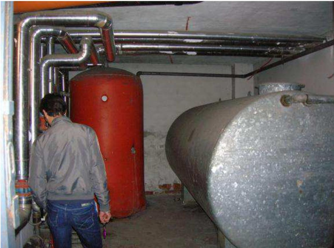
*Foto 11 – serbatoio acqua fredda e boiler acqua calda*
