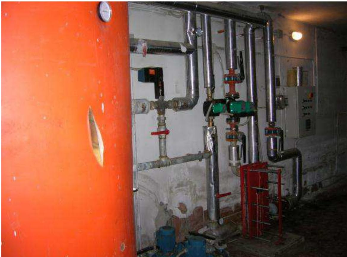
*Foto 18 – boiler acqua calda e pompe circuito acqua calda*
