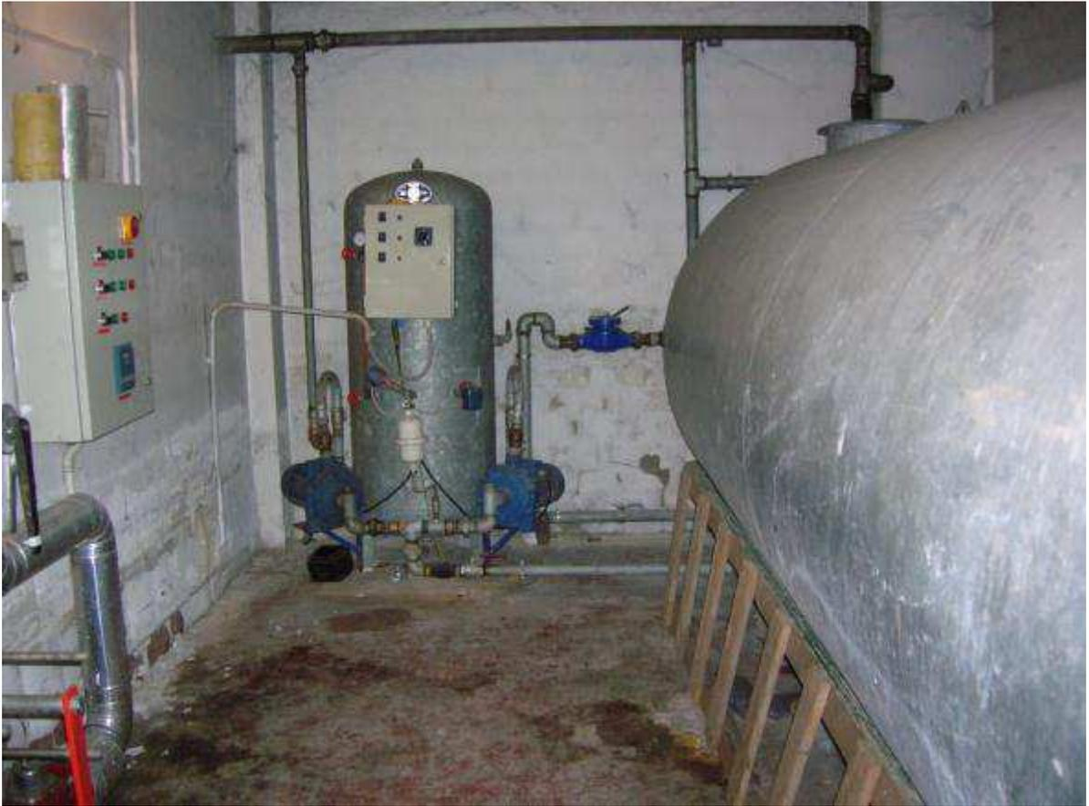
*Foto 17 – serbatoio accumulo acqua fredda e autoclave*
