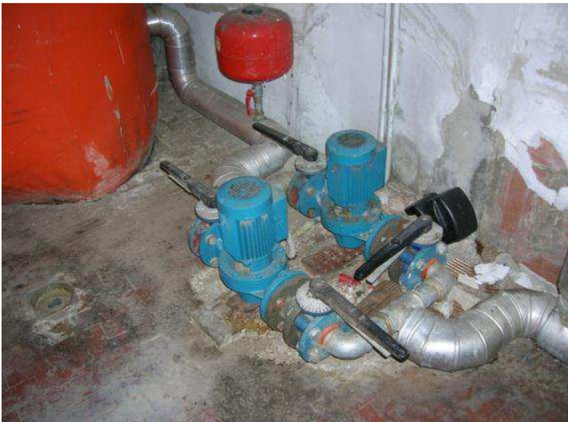
*Foto 23 - pompe circuito acqua calda*
