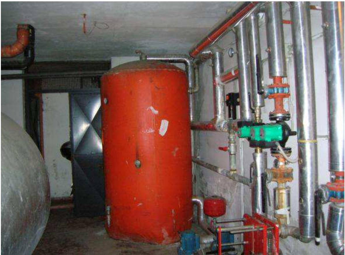
*Foto 19 - boiler acqua calda e pompe circuito acqua calda*
