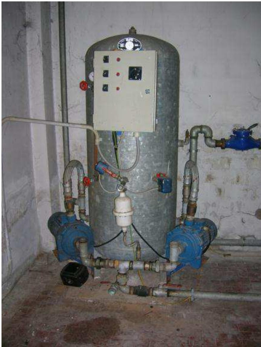
*Foto 21 – autoclave e quadro elettrico*
