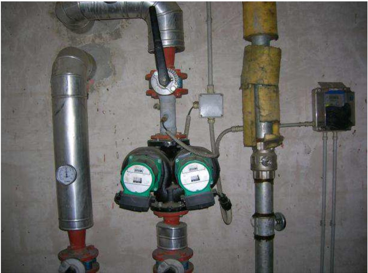
*Foto 16 – pompe circuito acqua calda*
