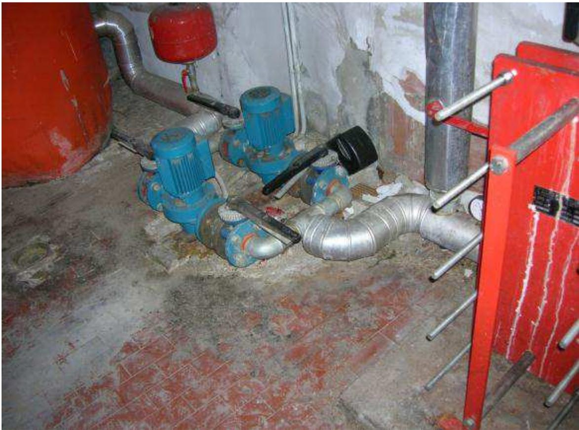
*Foto 22 – pompe circuito acqua calda*
