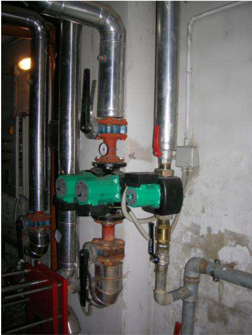
*Foto 9 – Pompe circuito acqua calda*
