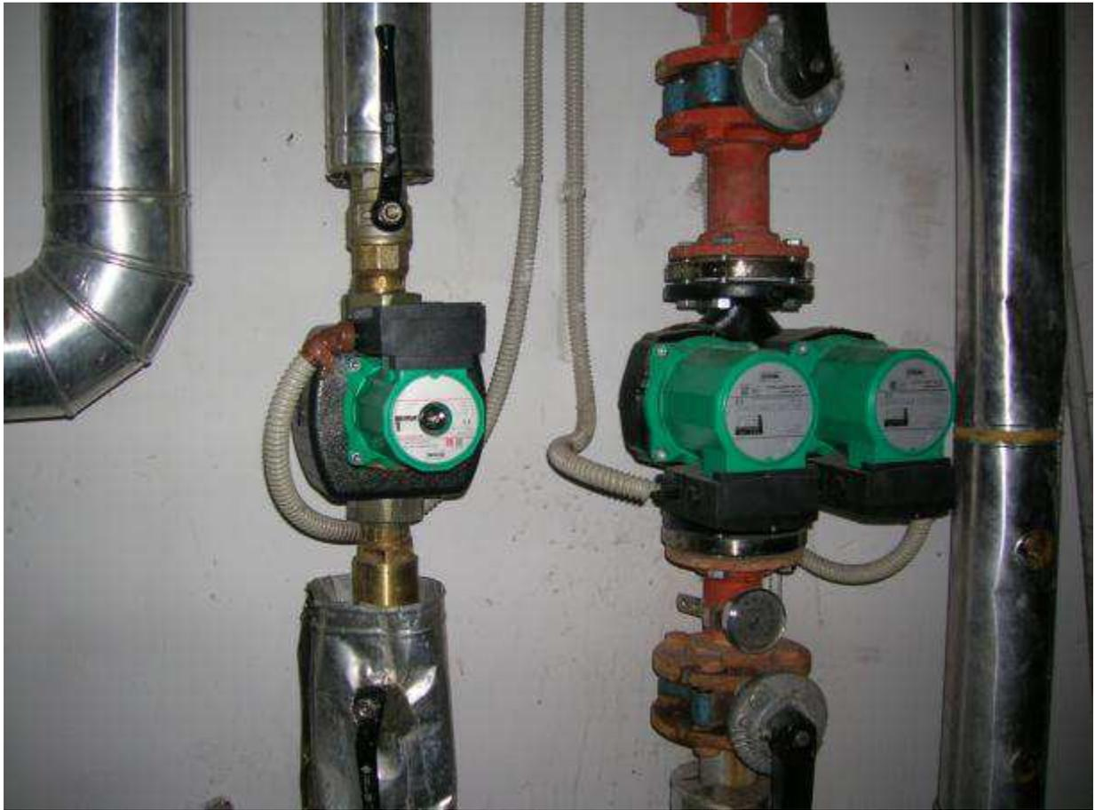
*Foto 24 – pompe circuito acqua calda*
