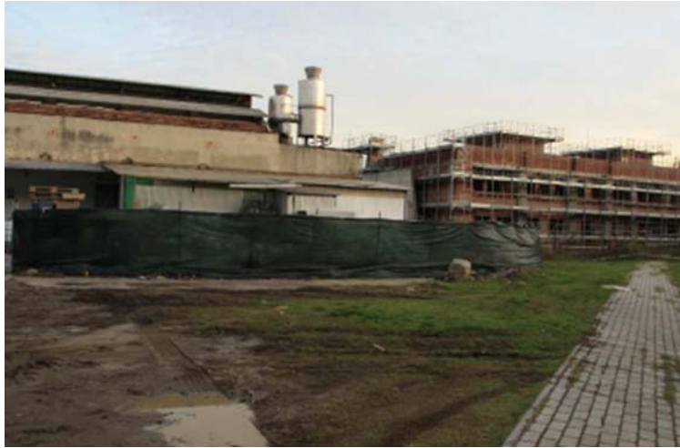
Fig. 5 – Foto del capannone artigianale situato ad est rispetto alla sorgente specifica.
